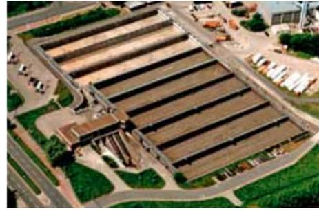
Das größte Regenüberlaufbecken (MVA hoch- und tiefliegend) mit einem Volumen von 40.000 m<sup>3</sup> liegt neben dem Müllheizwerk. Wenn es voll ist, fließt der Überlauf aus dem Becken in die kleine Wümme.
