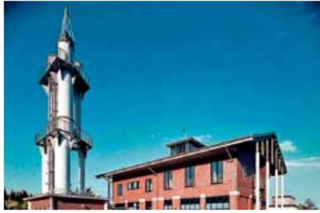
Das größte Pumpwerk ist das Mischwasser-Pumpwerk Findorff mit einem Wasserschloss, das an die Minarette einer Moschee erinnert. Das Pumpwerk wurde Mitte der neunziger Jahre neben dem alten Pumpwerk komplett neu errichtet. Das Wasserschloss dient zur Vermeidung von Druckstößen in den Abwasser-Druckleitungen
